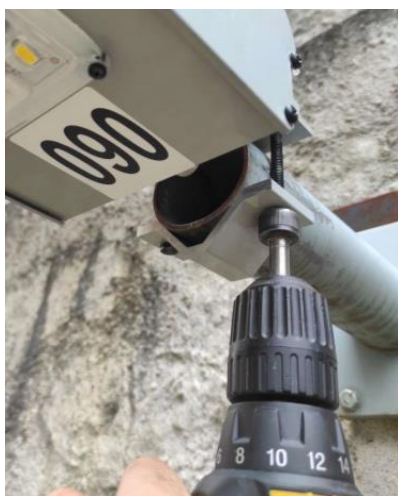
Foto 2 Fixação da luminária no braço
