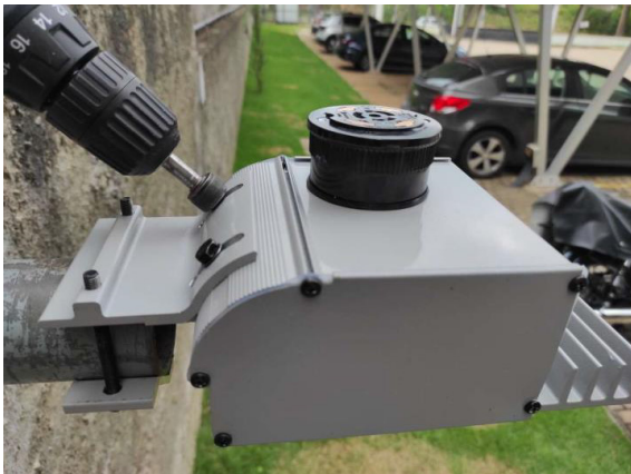
Foto 3 Ajustar parafusos para regulagem de ângulo
